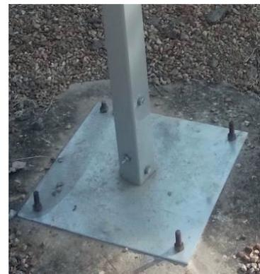
*Platine « de fixation » pour le poteau de la boîte avant et après installation.*
