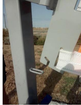
Après avoir enlevé le cas échéant le cadenas (non fourni), déployez progressivement la barrière en tirant sur la poignée jusqu'à atteindre le poteau d'arrimage. Positionnez la fente sous la poignée sur la boucle d'arrimage du poteau.
