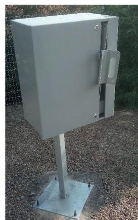
Enfoncez le poteau de la boîte sur la partie de la platine de fixation qui dépasse du sol. Utiliser les vis fournies pour fixer l'ensemble en place.
