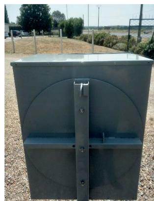
Déverrouillez la goupille, faites tourner la boîte pour la remettre dans la position initiale puis remettez la goupille en place.
