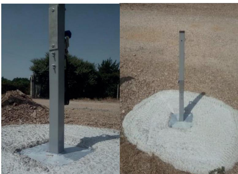
Une fois le béton prêt (laissez sécher 7 jours idéalement), vérifiez que le fourreau est vide et y insérer le poteau d'arrimage.
