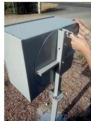
Vous pouvez maintenant faire pivoter la boîte en position horizontale, ce qui permettra un enroulement sans encombre. Remettez la goupille en place. Si ce n'est pas fait, détendez la sangle pour pouvoir enlever la bague, puis faites tourner la barrière pour atteindre une position horizontale.
