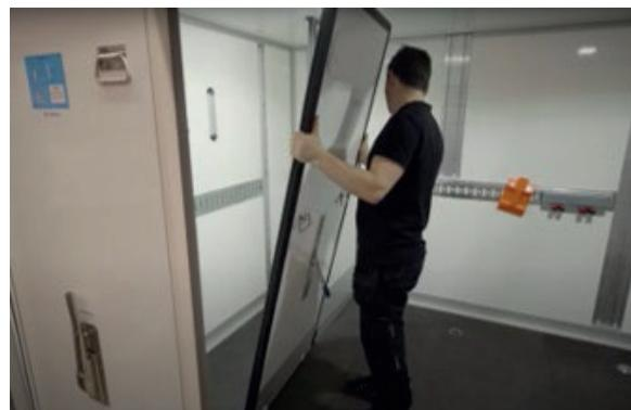
Lorsque la thermoparoie est inclinée d'environ 4 à 24°, les billes sont en contact avec le sol, ce qui permet un déplacement précis de la paroi dans toutes les directions pour son positionnement final.
