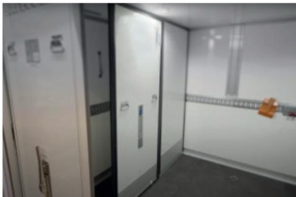
Wall On Wheel est revêtue sur l'avant et l'arrière d'un stratifié en fibre de verre à haute résistance, ce qui prolonge la durée de vie de la paroi. Le profilé inférieur en aluminium des sections de la paroi est nervuré, augmentant la friction au sol.
