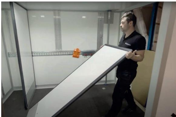
Lorsque la thermoparoie est inclinée d'environ 24 à 90°, les roues sont en contact avec le sol, ce qui facilite le déplacement de la paroi sur de plus longues distances.
