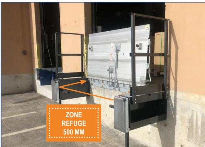
Système permettant de répondre à la norme NF EN349 et au guide technique ED6059 de l'INRS dans le but de limiter le risque d'écrasement des personnes.
