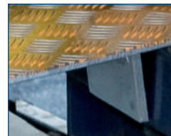
En partie haute, une cornière servant de butée
