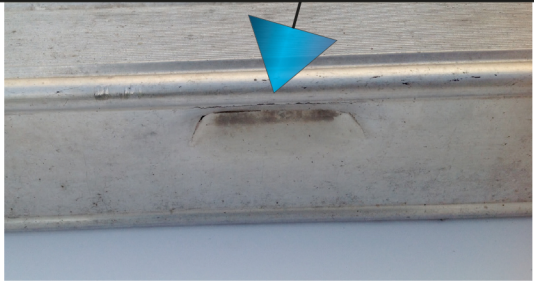
Profil présentant une déformation accidentelle, type coup de fourche
